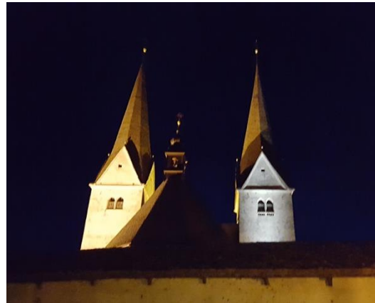
Beleuchtungstest Wehrkirche Diex: linker Turm: 250 W Natrium-Dampf-Lampe rechter Turm: 30 W LED
