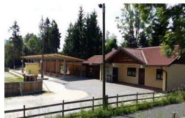
links die neue Überdachung
