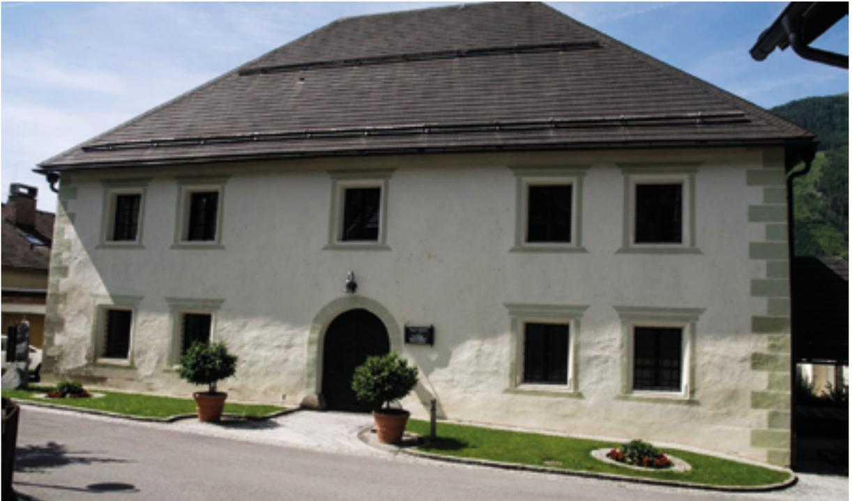
Der alte Pfarrhof in Malta verwandelt sich durch Sanierungs- und Umbaumaßnahmen zu einem besonderen Ort. Fenster und Heizung wurden erneuert und die oberste Geschoßdecke isoliert. Eine mobile Trennwand ermöglicht den frisch gestrichenen Raum zu teilen, um die Räumlichkeiten so noch besser nutzen zu können. Der neu errichtete Treppenlift gewährleistet barrierefreien Zugang für jedermann.
